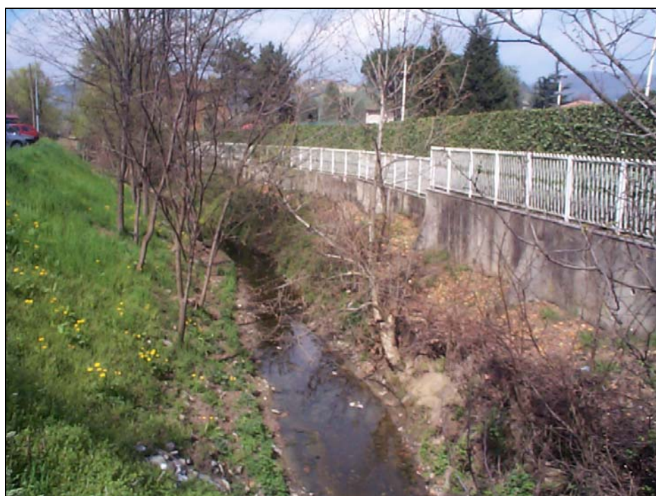
Roggia Castrina (n. 1) nei pressi del parcheggio della stazione ferroviaria
